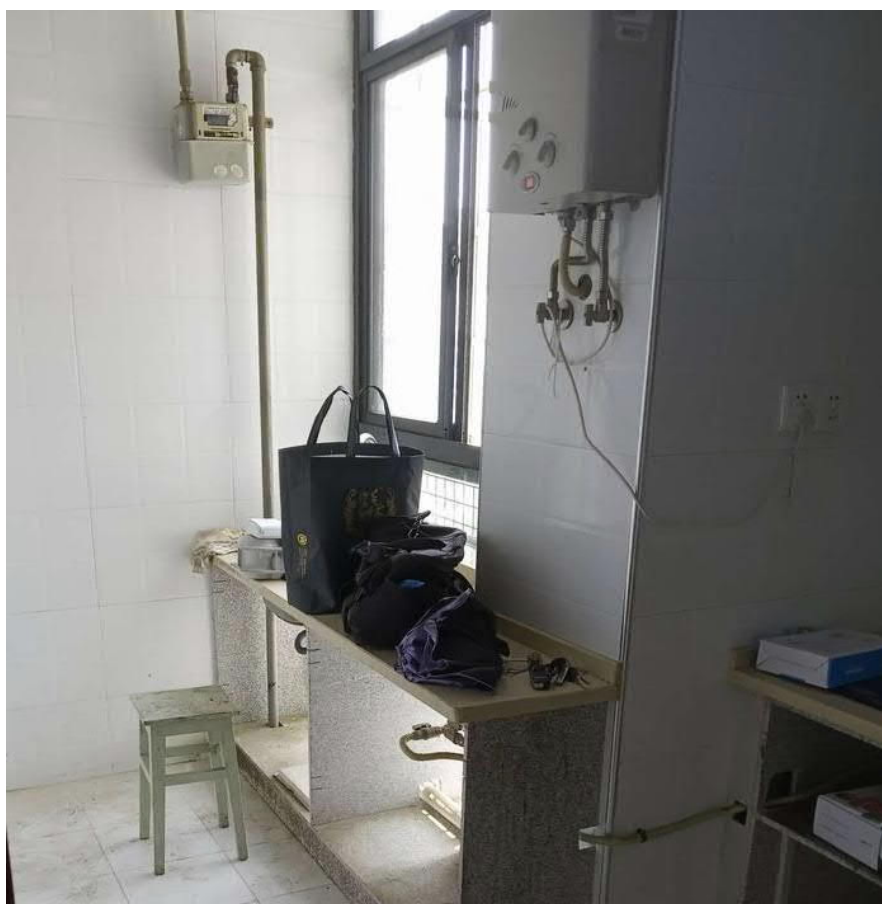
图 2 豹澥二期燃气立管安装于室内
