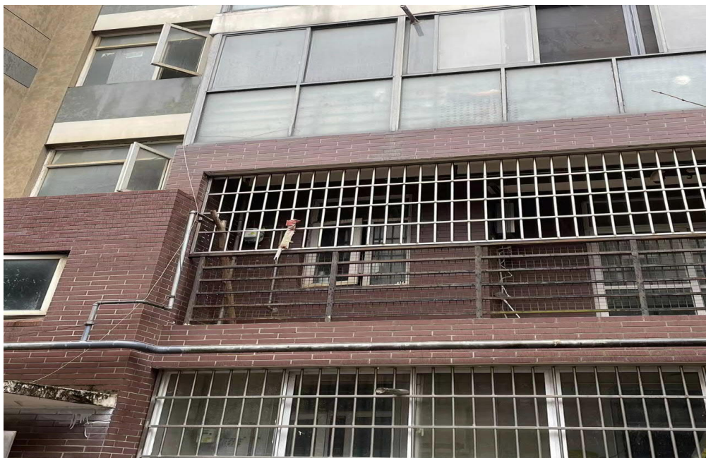
图 4.3-2 燃气立管安装于室内
